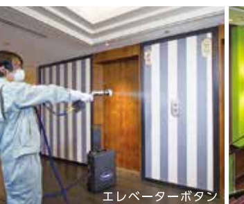
エレベーターボタン
